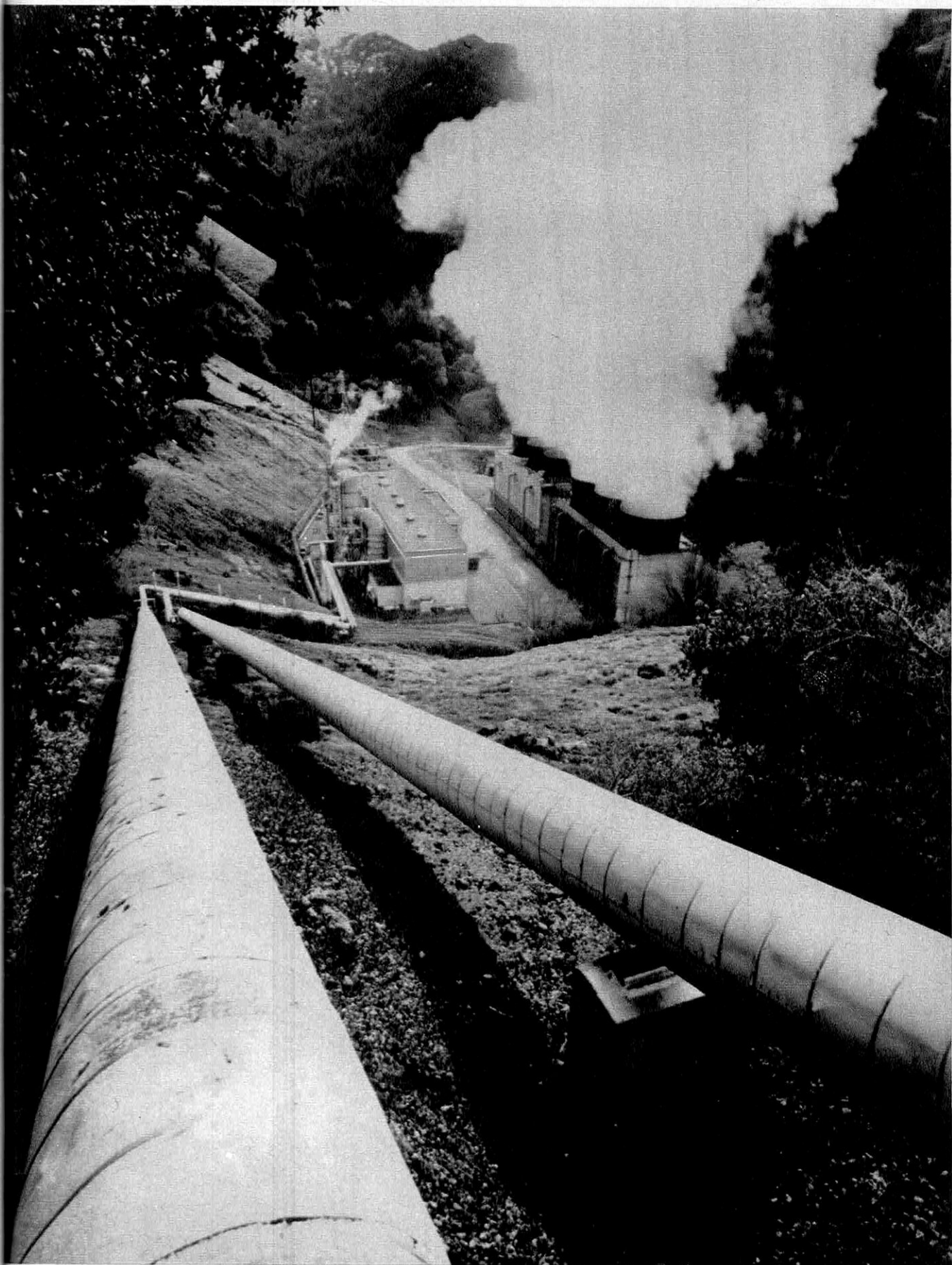
La centrale « The Geysers », en Californie du Nord, met à profit la vapeur du sous-sol pour faire tourner ses turbines. L'exploitation a débuté il y a quinze ans; sa puissance atteindrait 600 MW en 1975.
