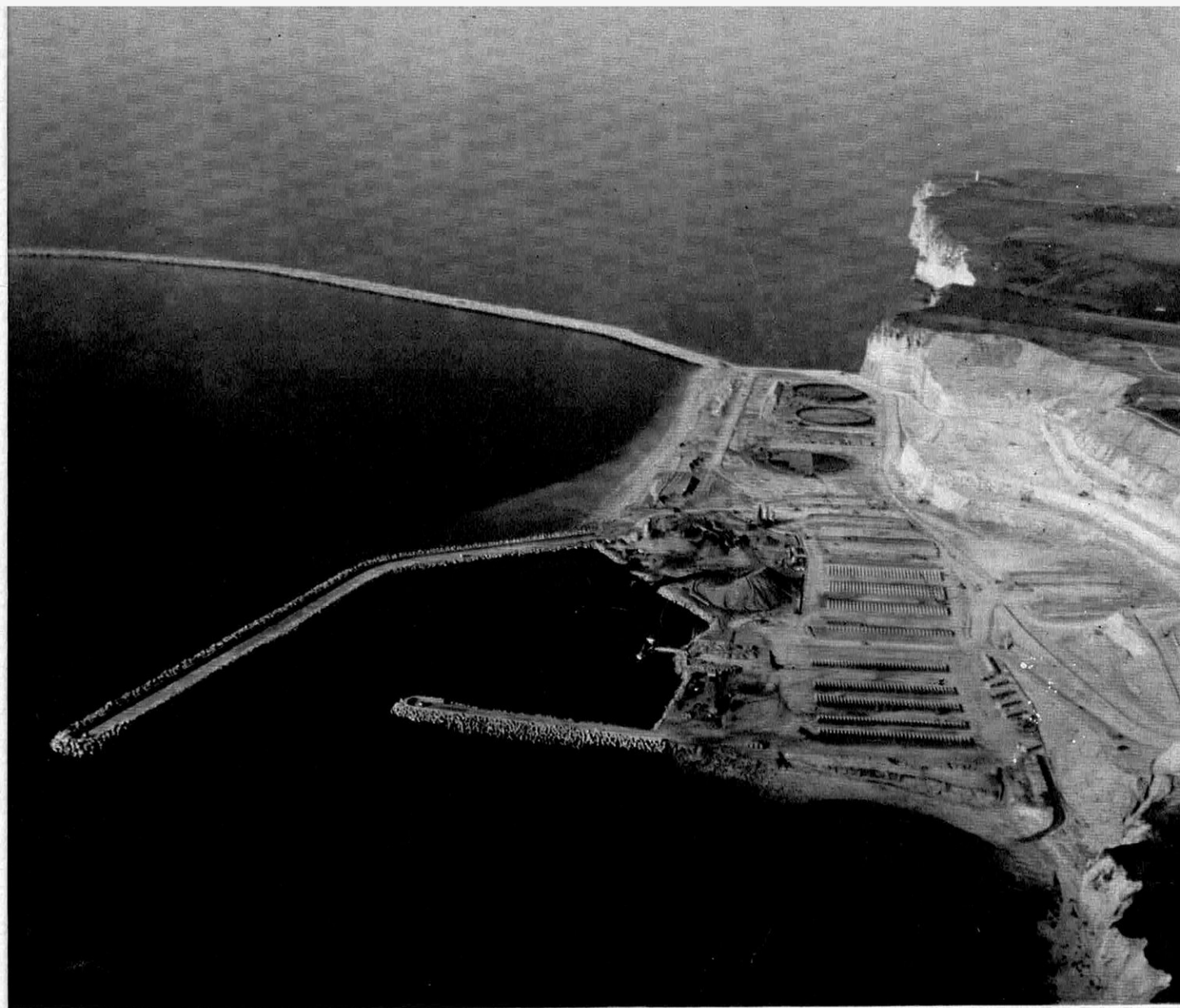
Le chantier du port d'Antifer, qui permettra le déchargement de pétroliers super-géants.
