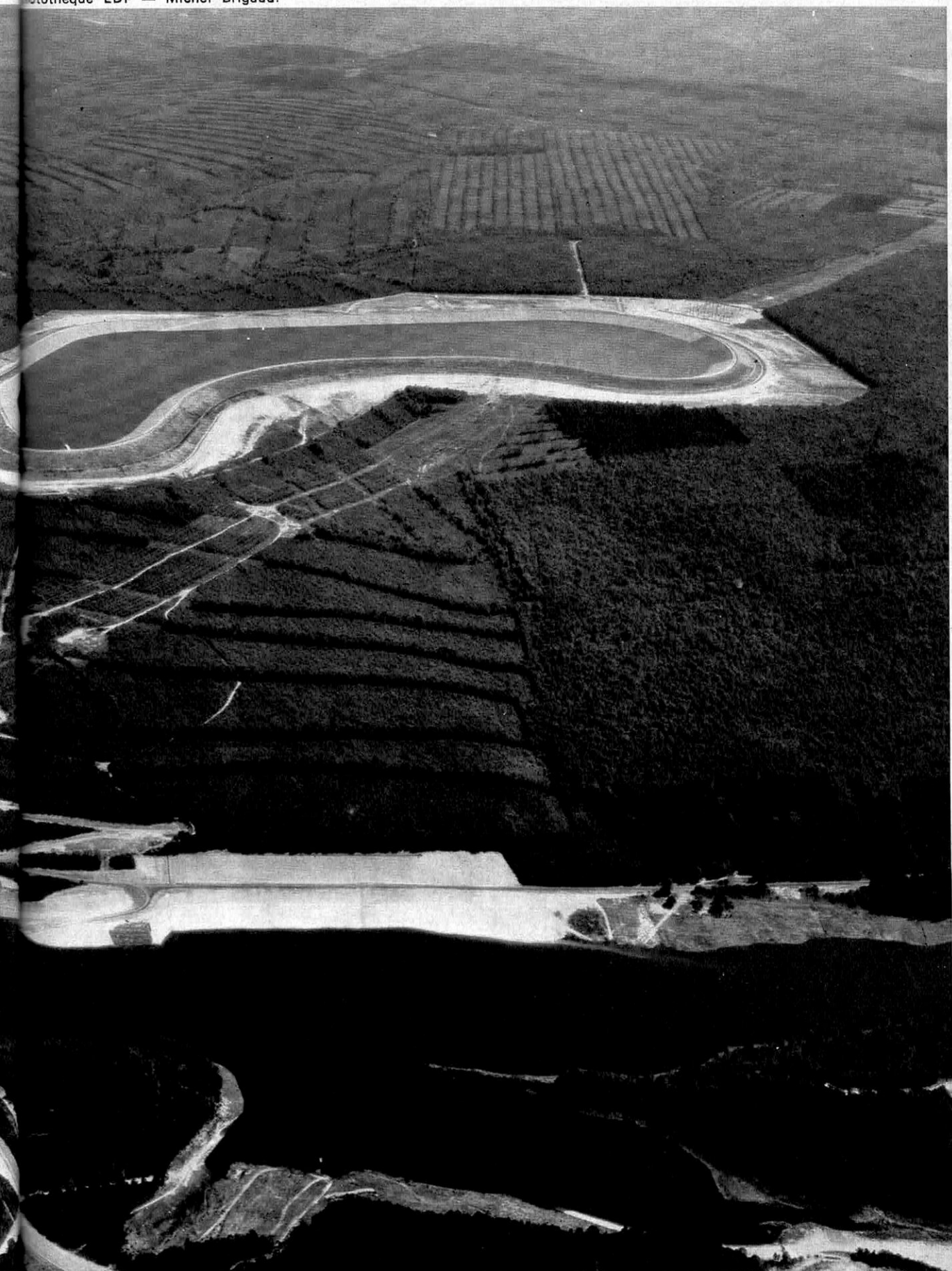
...si permet, aux heures de pointe, une production d'électricité supérieure.
