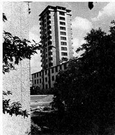
Drancy, 1932 : le 1 er système d'évacuation des ordures par le vide et, aussi, le 1 er tour d'habitation en Europe.
