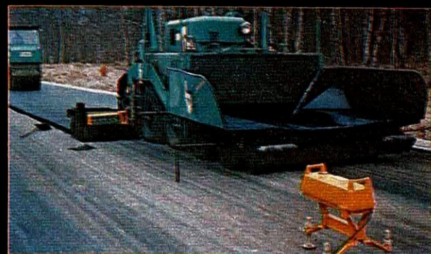
LE GUIDAGE DES ENGINS DE TRAVAUX PUBLICS.
