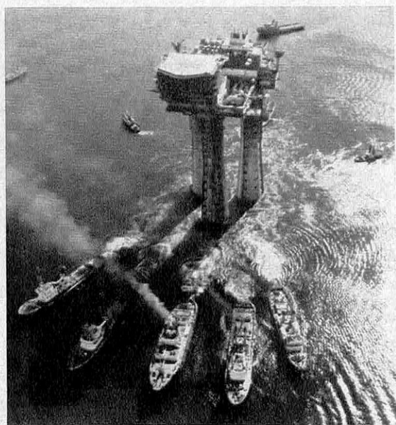
La plate-forme de production « Brent B » hauteur 160 m, poids 200 000 tonnes.
