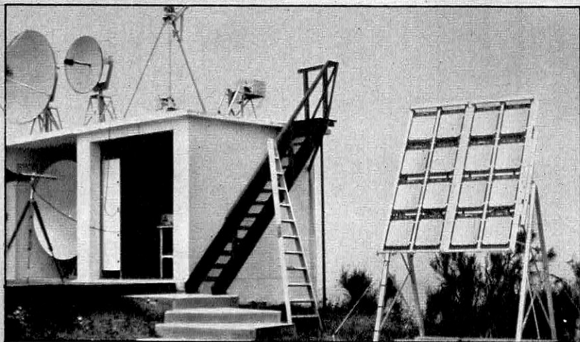
Station de télécommunication. La station de la Turbie a été réalisée en 1971 en coopération avec le Centre National des Télécommunications. Le générateur solaire alimente une batterie de 300 Ampères-heures qui assure le fonctionnement de l'installation 24 heures sur 24 en fournissant en permanence une puissance de 12 W.
