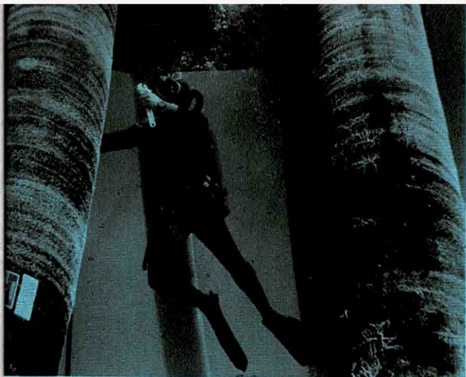
Plongeur autonome en équipement classique avec scaphandre à air comprimé, contrôlant un sealine (pipe-line sous-marin).
