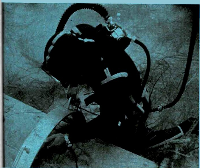
Plongeur vérificateur de sealine (installations pétrolières) équipé du narguilé (glène de caoutchouc débitant l'air) avec détendeur-régulateur dorsal.
