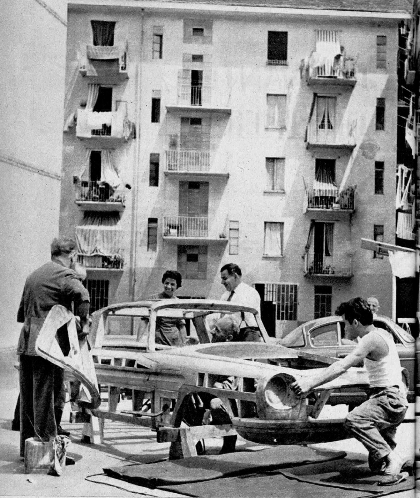
Dans cette cour, où l'on achève la charpente de la Lloyd (Allemagne), est née
