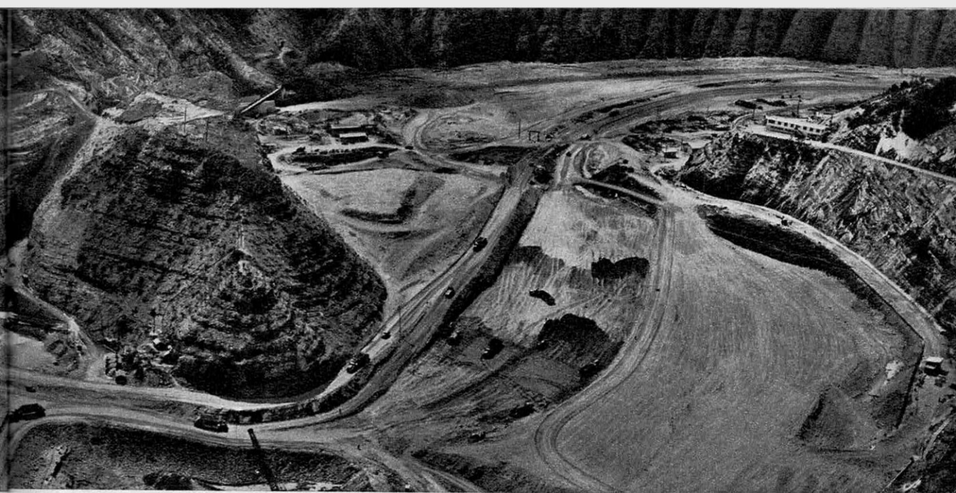
e des eaux. Sur le chantier, fourmilière géante, la ronde infernale des 31 camions.
