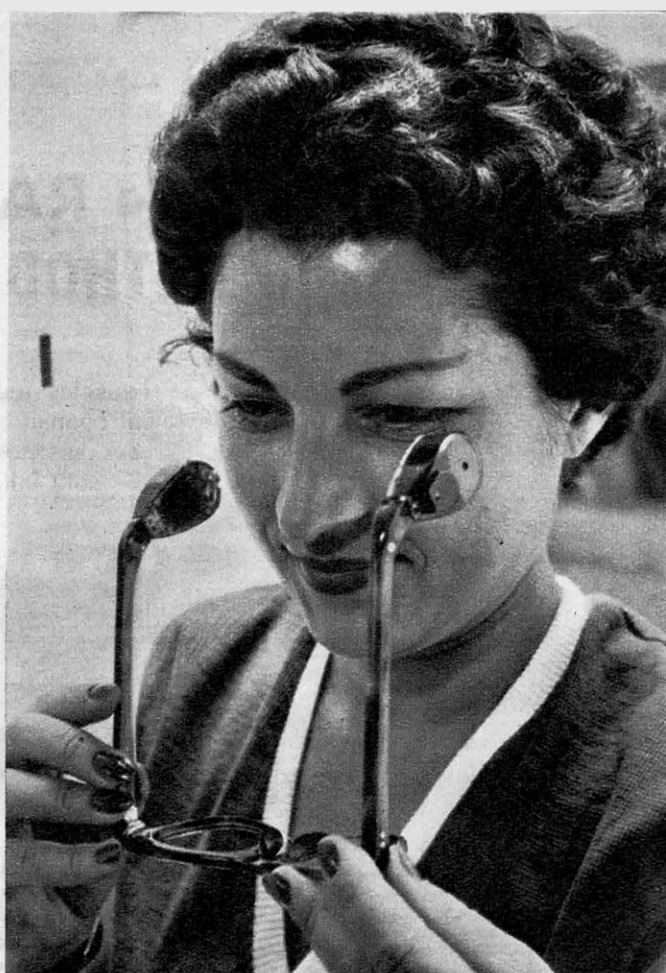
Dans la lunette « Acousticon », tout le câblage est incorporé dans une seule branche.
