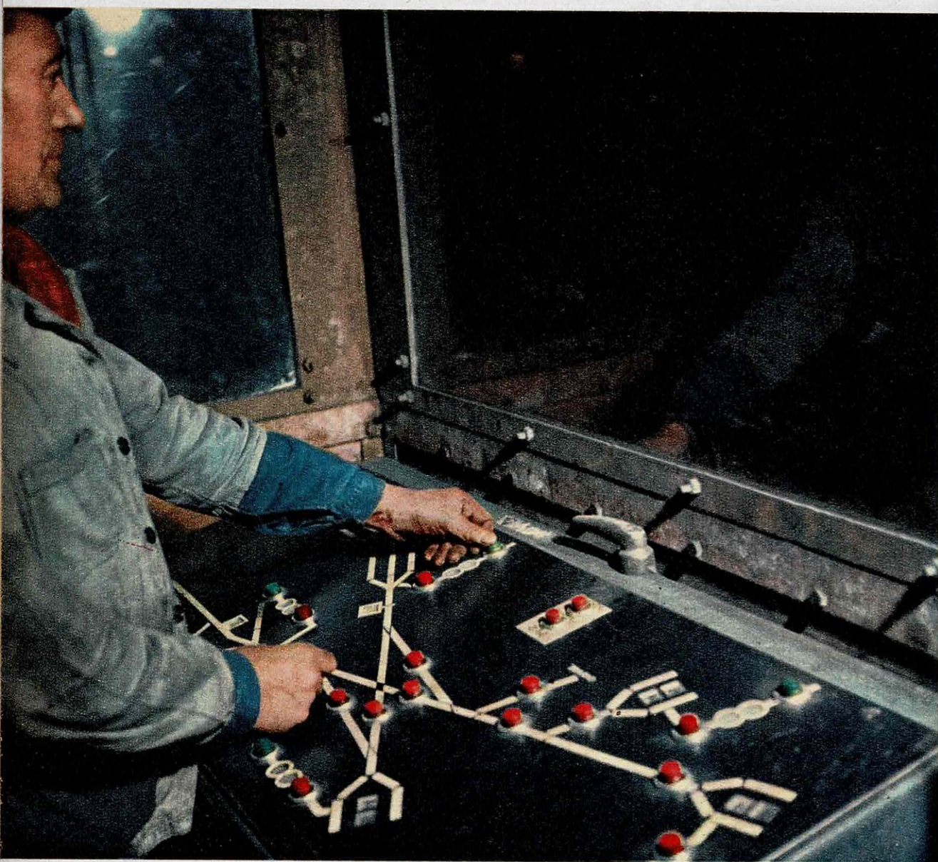
Sur ce tableau lumineux devant le « dispatcheur » est reproduit tout le réseau ferré du fond.
