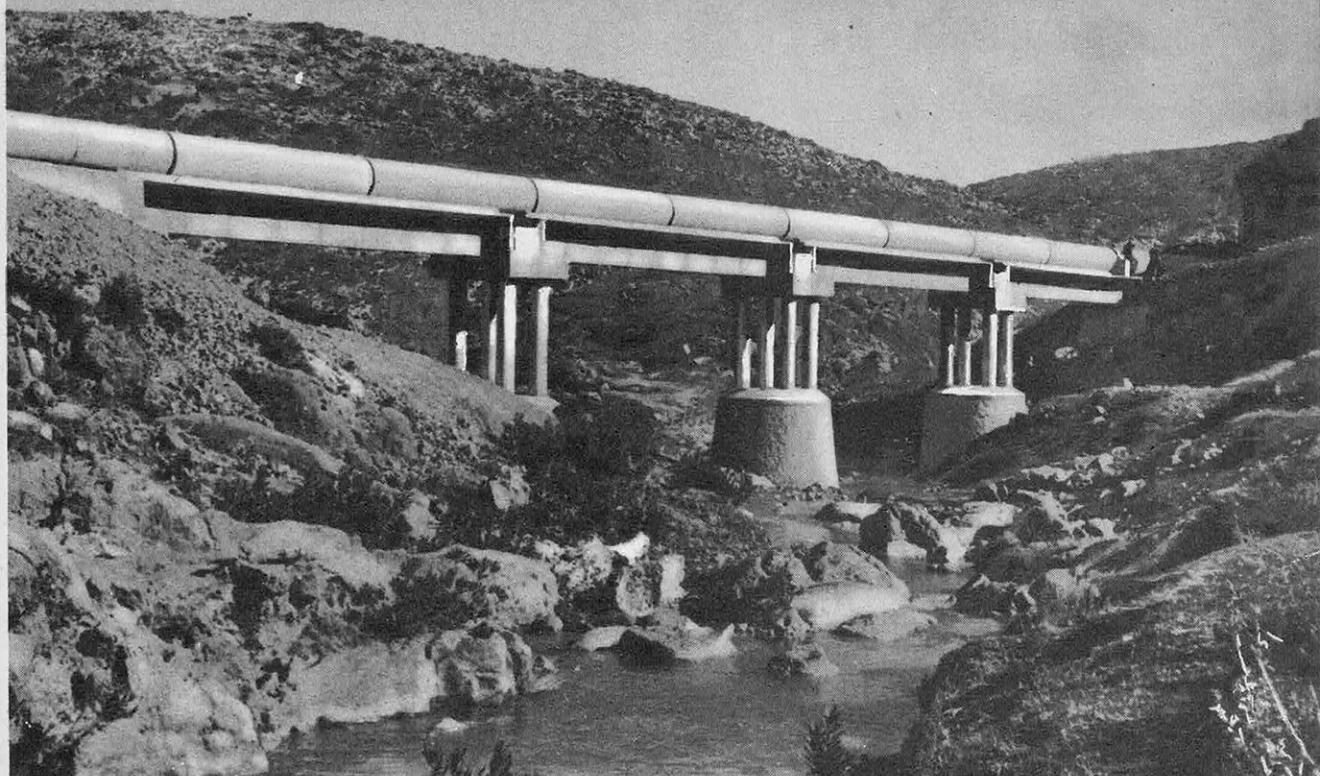
TRAVERSÉE DE L'OUED DE BOU MESSAOUD PAR LA CANALISATION QUI DESSERT ORAN
