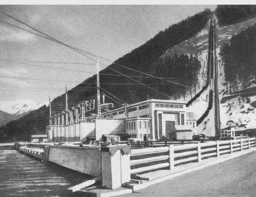
● L'usine de Malgovert (dont ci-contre la position géographique) est alimentée par deux conduites forcées de 2,1 à 2,2 m de diamètre.
