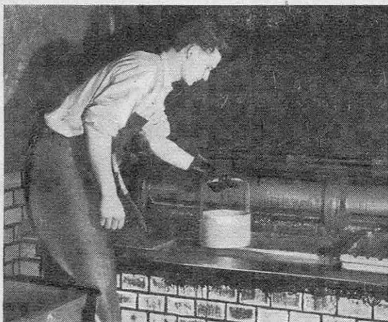
● Chaînes et motifs sont dégraissés par immersion dans une solution d'acides nitrique, chlorhydrique et sulfurique.
