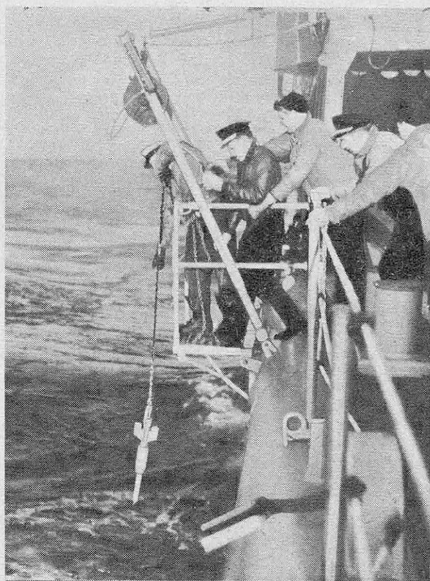
CETTE SONDE, une fois lâchée, ira se fichée dans le fond de la mer ; elle y découpera des « carottes échantillons » pouvant atteindre jusqu'à 90 cm de long.
