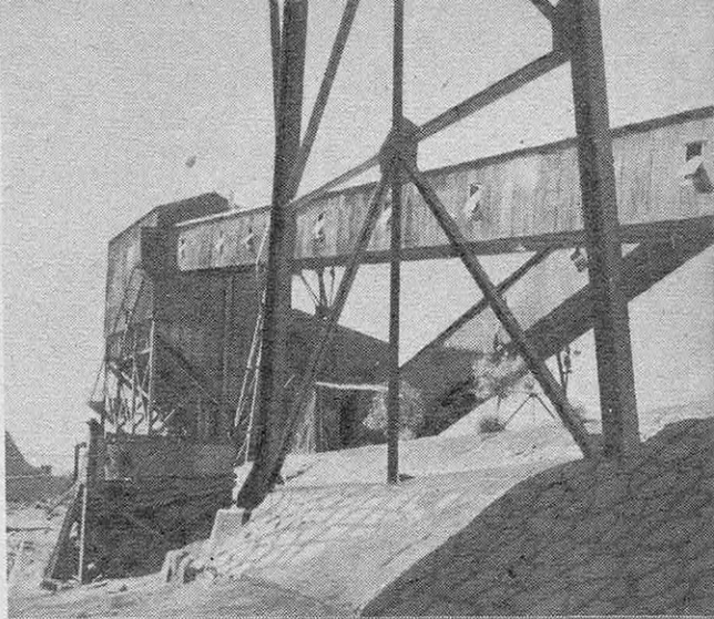
● Des convoyeurs mécaniques empruntant des couloirs d'accès les montent au sommet de l'installation.
