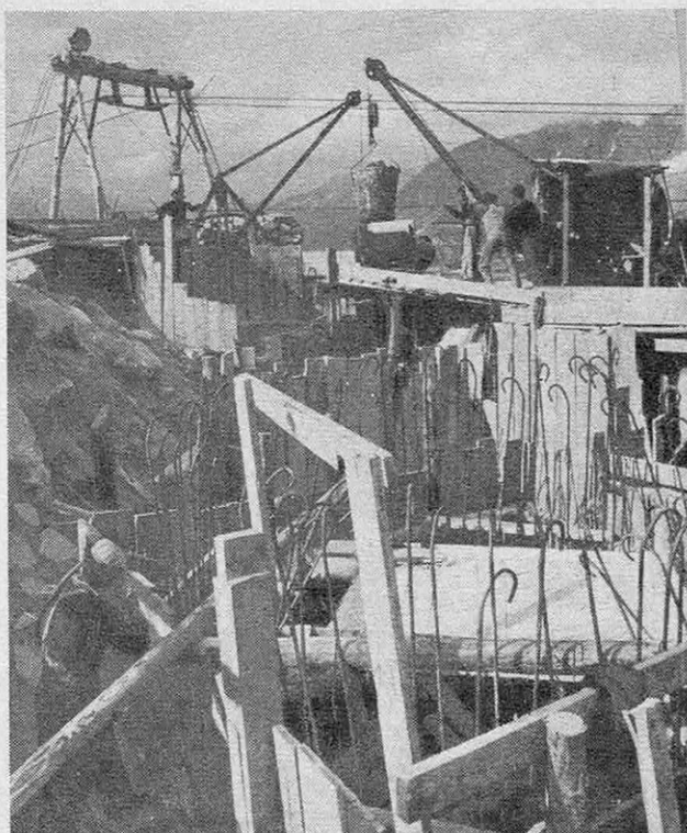
● Les travaux au replat intermédiaire du Plan de l'Aiguille : au premier plan, emplacement du pylône.
