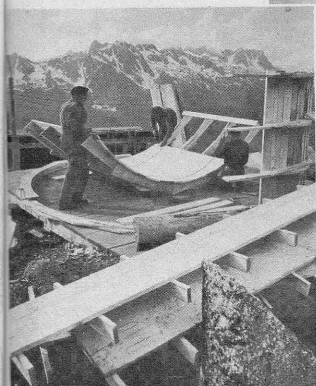
● Sur ce même Plan de l'Aiguille, préparation des éléments composant le coffrage du puits du pylône.
