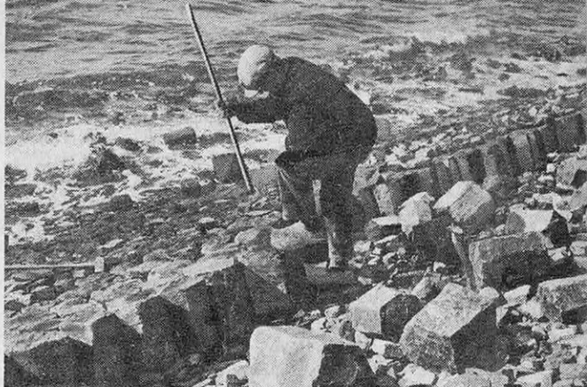
● La partie de la digue exposée au ressac des vagues est défendue par des blocs de basalte taillés en hexagones.
