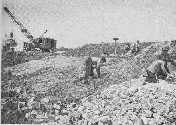
● Pour consolider la digue, on commence par répandre sur le talus une couche de paille que l'on alourdit de pierres.
