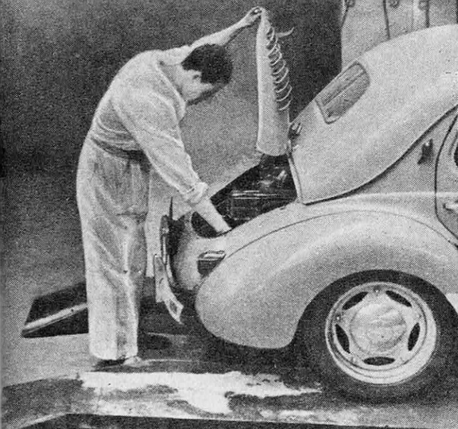
● Graissages et pulvérisations protègent les ressorts à boudin, organes qui sont très exposés.
