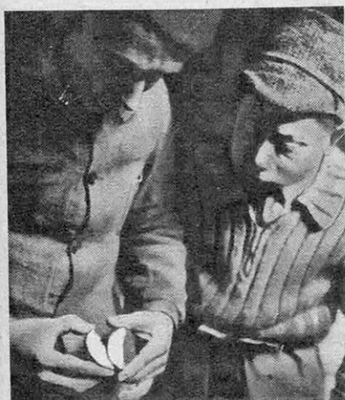
5 Le maître fondeur vérifie que le grain de métal est serré. Si c'est le cas, la coulée s'annonce bonne.
