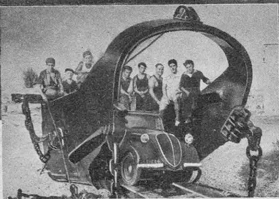
● Cet immense godet où tiennent sans difficulté une auto et huit hommes, c'est la benne du drag-line qui, sur l'autre photo, creuse le débouché du canal dans le Rhône. On juge des proportions de l'engin ! Cette pelle américaine Marion de 550 ch creuse 5 à 600 m 3 à l'heure. Pour se déplacer, elle avance des patins latéraux sur lesquels, par des excentriques, elle prend appui pour retomber en avant.
