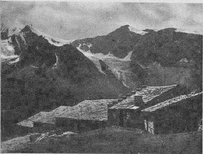
● Chalets d'alpage (Saas Grund, Valais) construits dans le sens du glissement de l'avalanche et disposés de façon qu'elle puisse passer dessus sans les endommager.
