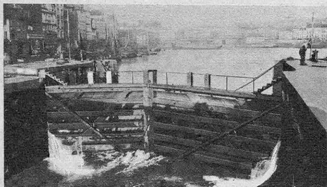
● L'azobé « Lophira procera » du Cameroun, bois extrêmement dur et imputrescible, convient parfaitement aux ouvrages maritimes, telle la porte d'écluse ci-dessus. Mais, susceptible de multiples applications, il confère aux charpentes lamellaires une qualité encore supérieure. La Compagnie Française du Gabon en fait actuellement construire une de 24 m × 100 m d'une seule portée.
