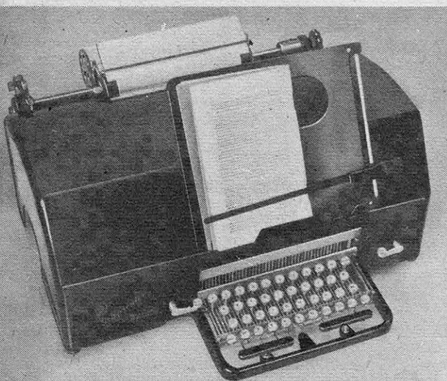
● Appareil Creed. Sur ce téléimprimeur, la frappe du texte reste en retard d'une lettre sur celle du clavier.
