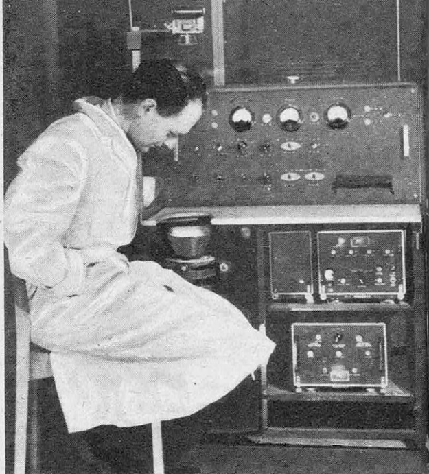
● L'ingénieur observe l'évolution des échos sur l'écran d'un récepteur. Un appareil photographique situé au-dessus de l'écran en prend des images à intervalles réguliers.
