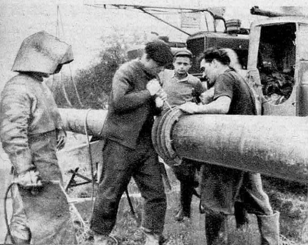
1 Les tubes en acier, de 6 à 8 m de long, sont alignés à l'aide d'une grue. L'assemblage provisoire, ci-dessus, permettra d'effectuer la première soudure.
