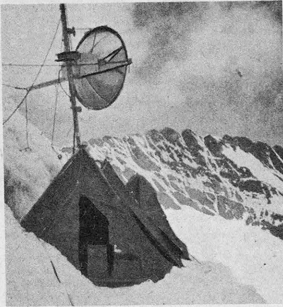
● Essais de transmission par ondes dirigées, de 15 cm de longueur à la Pointe Mathilde (massif de la Jungfrau) à 3 560 m d'altitude. L'antenne utilisée ici comporte un réflecteur parabolique orienté vers la station réceptrice.
