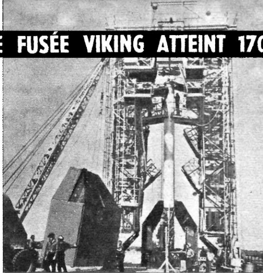
● A White Sands (Nouveau-Mexique), la fusée installée dans son échafaudage mobile ; on enclôt sa base dans un abri métallique spécial.
