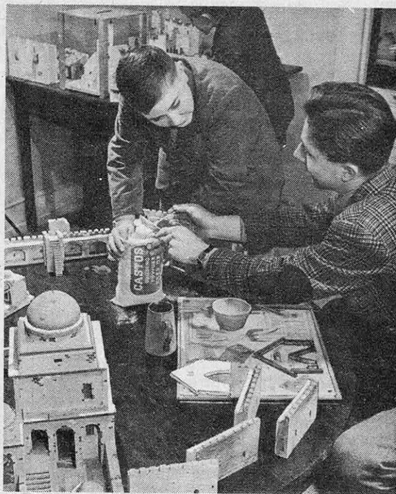
● Là, la méthode de construction, plus évoluée encore, s'inspire, pour la confection d'éléments préfabriqués, des procédés utilisés dans la technique du béton (Castos).
