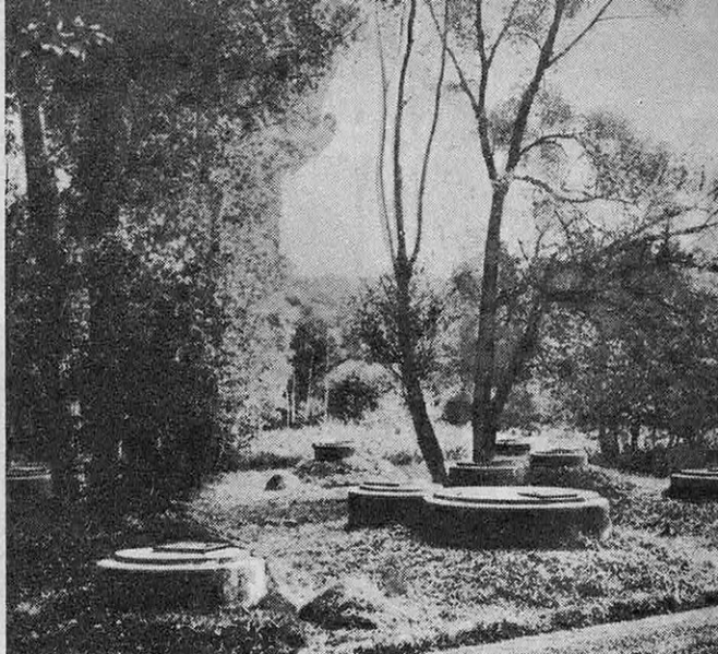
Têtes des puits de captage des sources de Bourron, dont les eaux ne s'écouleront jamais dans le Loing.
