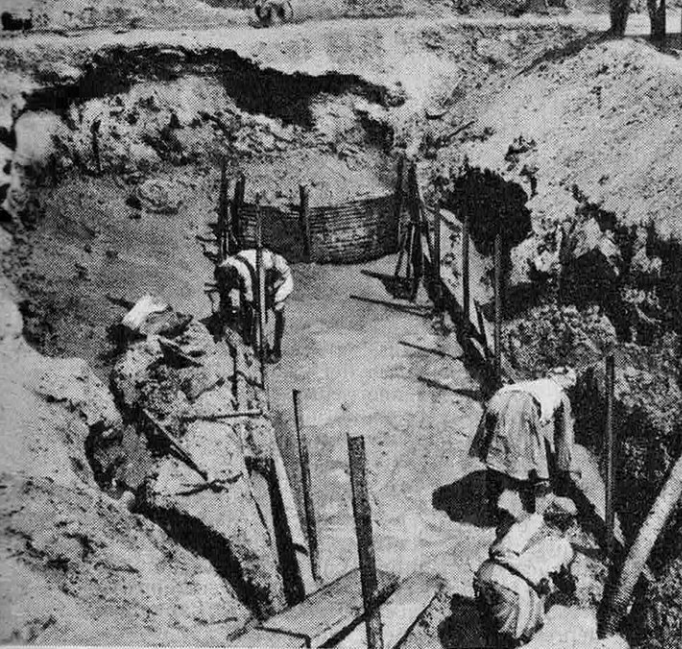
FOUILLE. En certains points, comme celui-ci (au km 59 est), les investigations sont plus poussées encore et descendent sous forme de fouilles jusqu'à la cote maximum.
