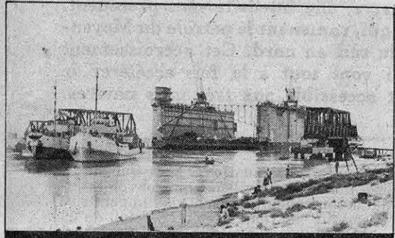
Passage d'un pont tournant par un dock flottant anglais, ramené d'Orient. Il fallut, pour lui, relever les bouées marquant les fonds de 8 m.
