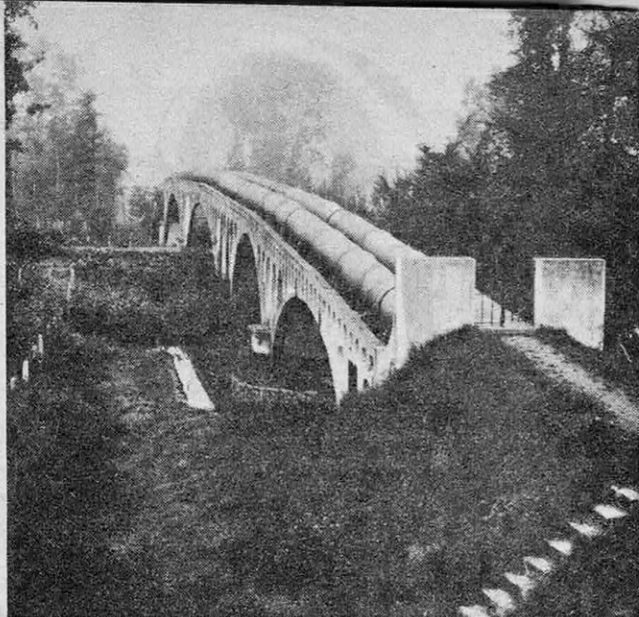
Le siphon de Moret-sur-Loing porte successivement les eaux au-dessus de l'Orvanne, du canal et du Loing.
