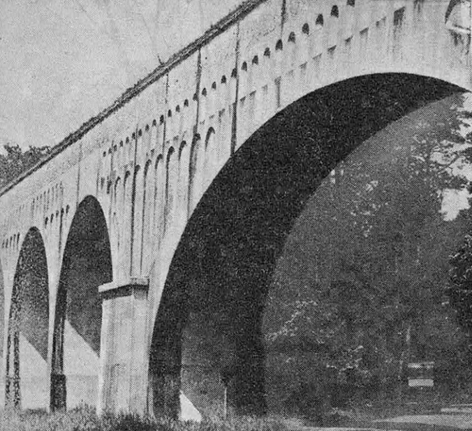
A travers la forêt de Fontainebleau, cet aqueduc conduit vers Paris les eaux captées de la Vanne et du Loing.
