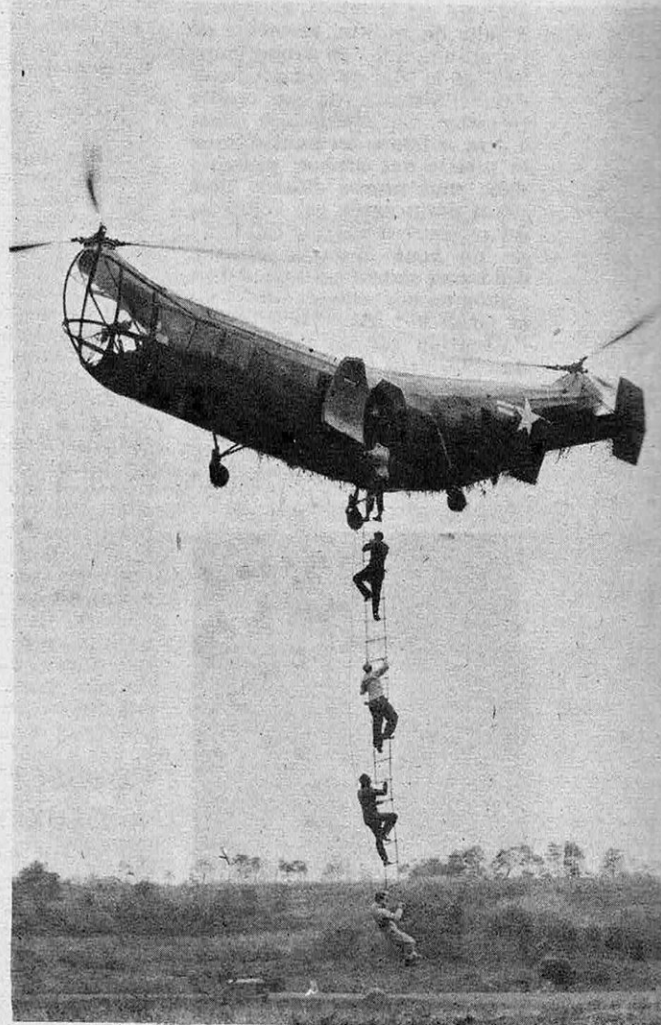
Fig. 13 : Un hélicoptère Piasecki HRP 1' effectuant une démonstration de sauvetage. — Neuf à dix personnes peuvent être recueillies de cette manière par cet hélicoptère.
