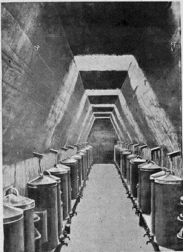
FIG. 4. — LES EAUX DE DRAINAGE DES CASES OU SONT EFFECTUÉES LES CULTURES EXPÉRIMENTALES SONT RECUEILLIES AUX FINS D'ANALYSE DANS DES RÉCIPIENTS ALIGNÉS DANS UN TUNNEL PASSANT SOUS CES CASES
