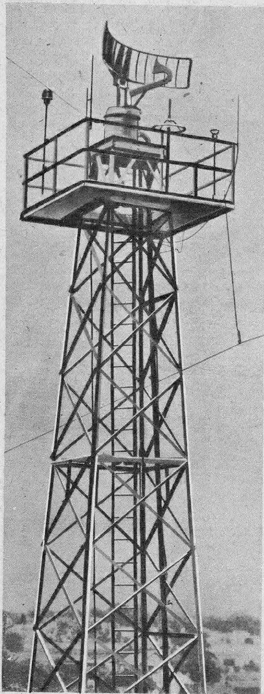
FIG. 7. — ANTENNE TOURNANTE DE RADAR D'AÉROPORT
