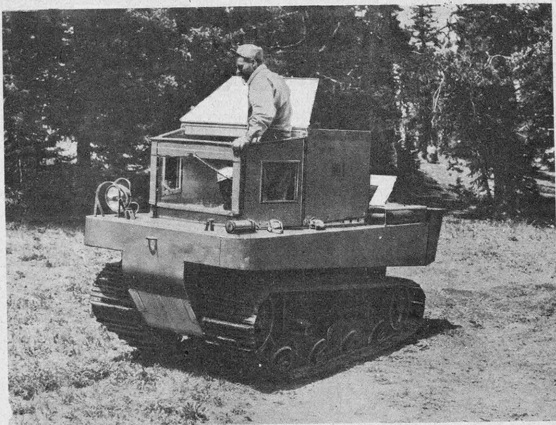
FIG. 2. — UN « WEASEL » M. 29, TYPE DES VÉHICULES À CHENILLES QUI REMPLACERONT LA CLASSIQUE TRACTION PAR CHIENS DANS LES EXPÉDITIONS POLAIRES
