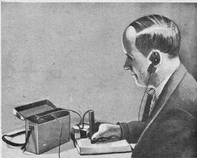
FIG. 1. — L'AVEUGLE DÉPLACE LE LECTEUR PHOTOÉLECTRIQUE LE LONG DE CHAQUE LIGNE : CHAQUE LETTRE SE TRADUIT PAR DES SONS DIFFÉRENTS
