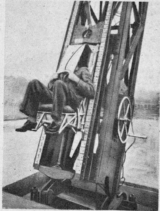
FIG. 10. — LE SIÈGE MARTIN-BAKER FIXÉ À L'AFFUT-GLISSIÈRE POUR LES ESSAIS AU SOL
