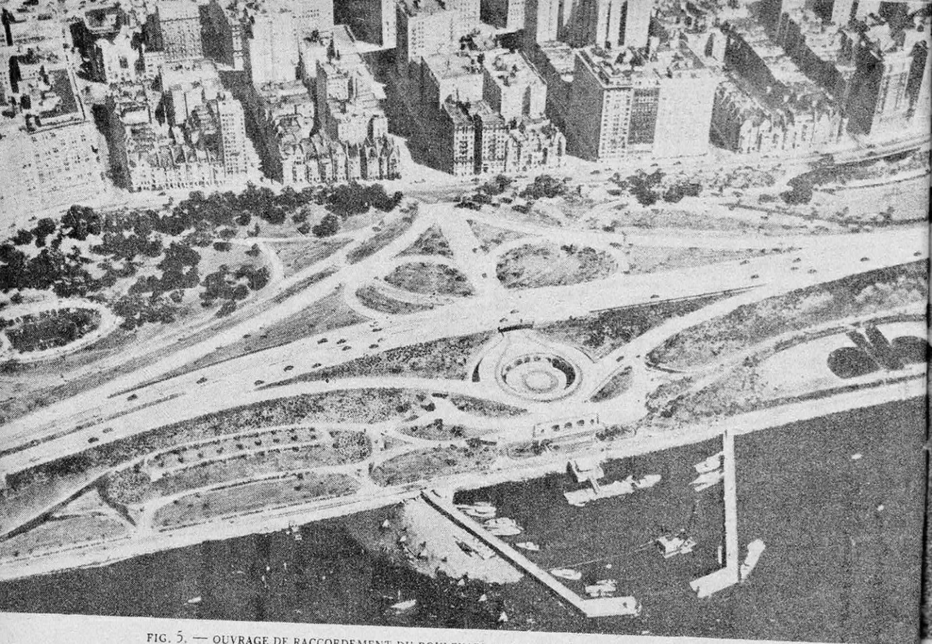
FIG. 5. — OUVRAGE DE RACCORDEMENT DU BOULEVARD HENRI HUDSON AVEC LA 79 e RUE, A NEW YORK
