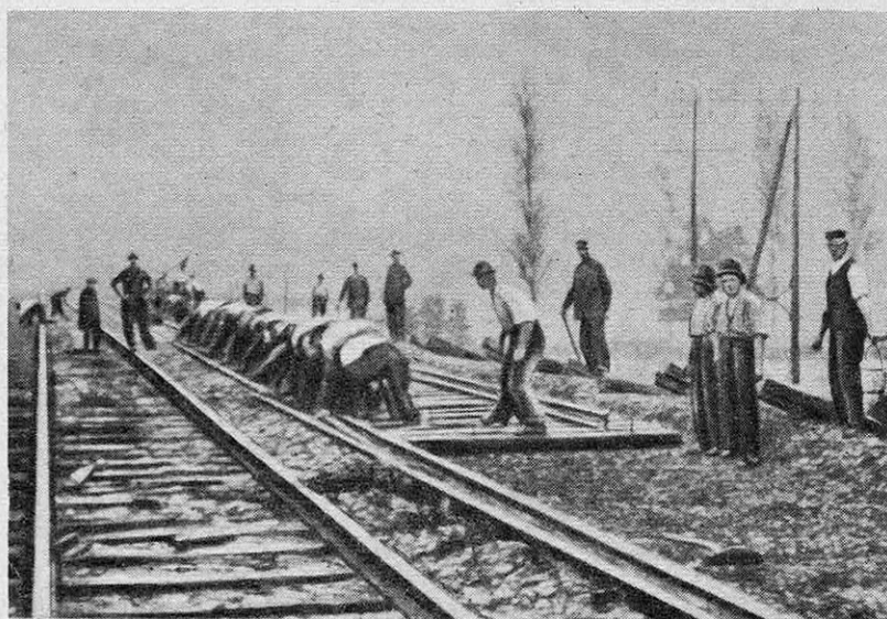
FIG. 19, 20 ET 21. — RENOUVELLEMENT MANUEL DE LA VOIE
