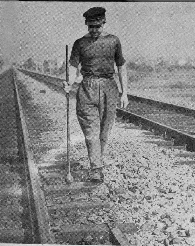
FIG. 11, 12 ET 13. — REPÉRAGE DES TRAVERSES « DANSEUSES »
