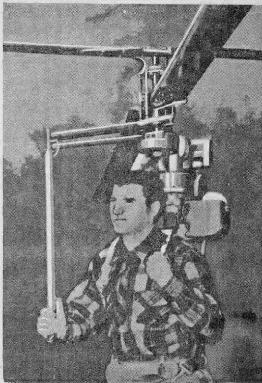
FIG. 4. — L'« HOPPICOPTER », LA PLUS PETITE MACHINE VOLANT AVEC UN PASSAGER
