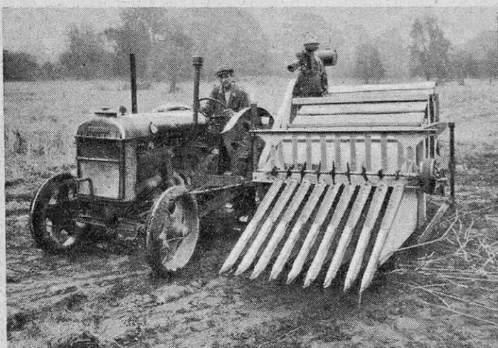
FIG. 6. — VUE AVANT DE L'ÉPIEUSE-BATTEUSE ANGLAISE
