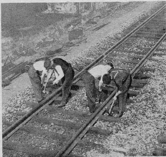
FIG. 7 ET 8. — REPRISE DU NIVELLEMENT PAR BOURRAGE DU BALLAST SUR LES TRAVERSES
