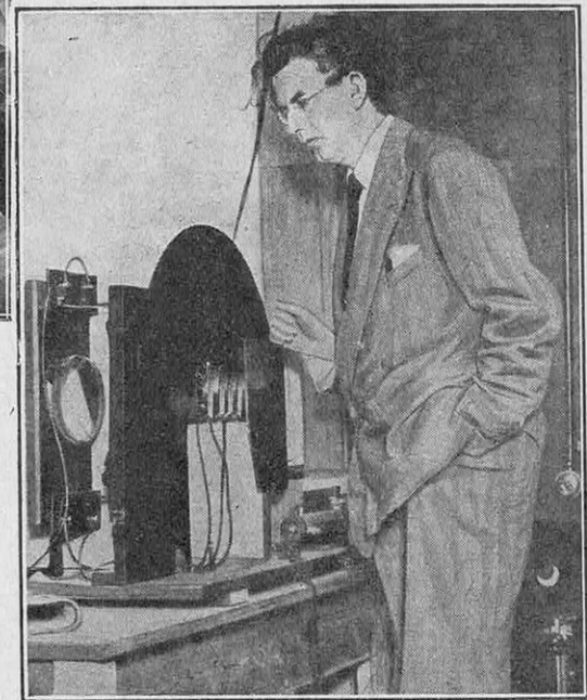
FIG. 15. — L'INVENTEUR BAIRD PROCÈDE A DE NOUVEAUX ESSAIS EN VUE DE RÉALISER LA TÉLÉVISION EN COULEURS
