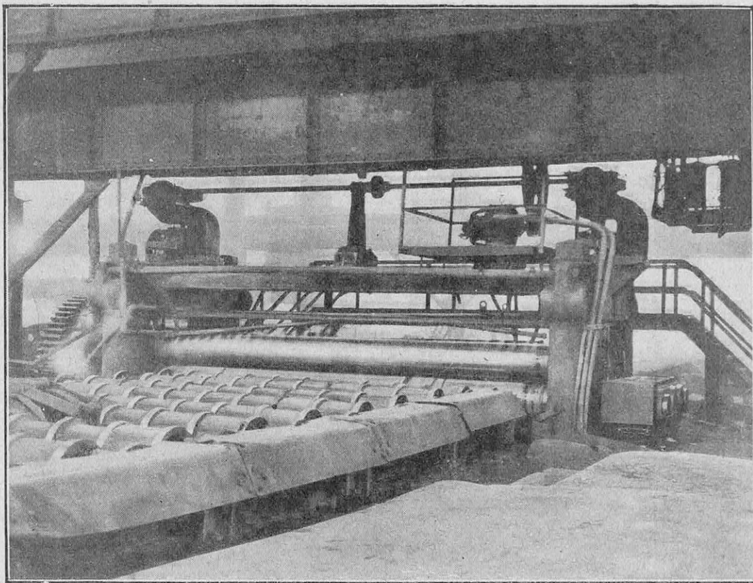
FIG. 3. — LAMINOIR DRESSEUR DE 5 M 25 POUR TOLES D'ACIER AU NICKEL
