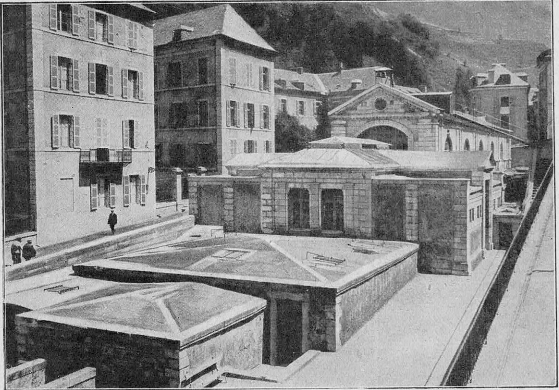
LES SOURCES SULFUREUSES DE BARÈGES (HAUTES-PYRÉNÉES), CAPTÉES ET COUVERTES THE SULFUROUS SPRINGS OF BARÈGES (HAUTES-PYRÉNÉES) (CUT DOWN AND COVERED)
