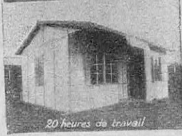
UNE MAISON DE QUATRE PIÈCES, COUVRANT 50 M 2 , QUI A ÉTÉ ÉDIFIÉE EN VINGT HEURES
