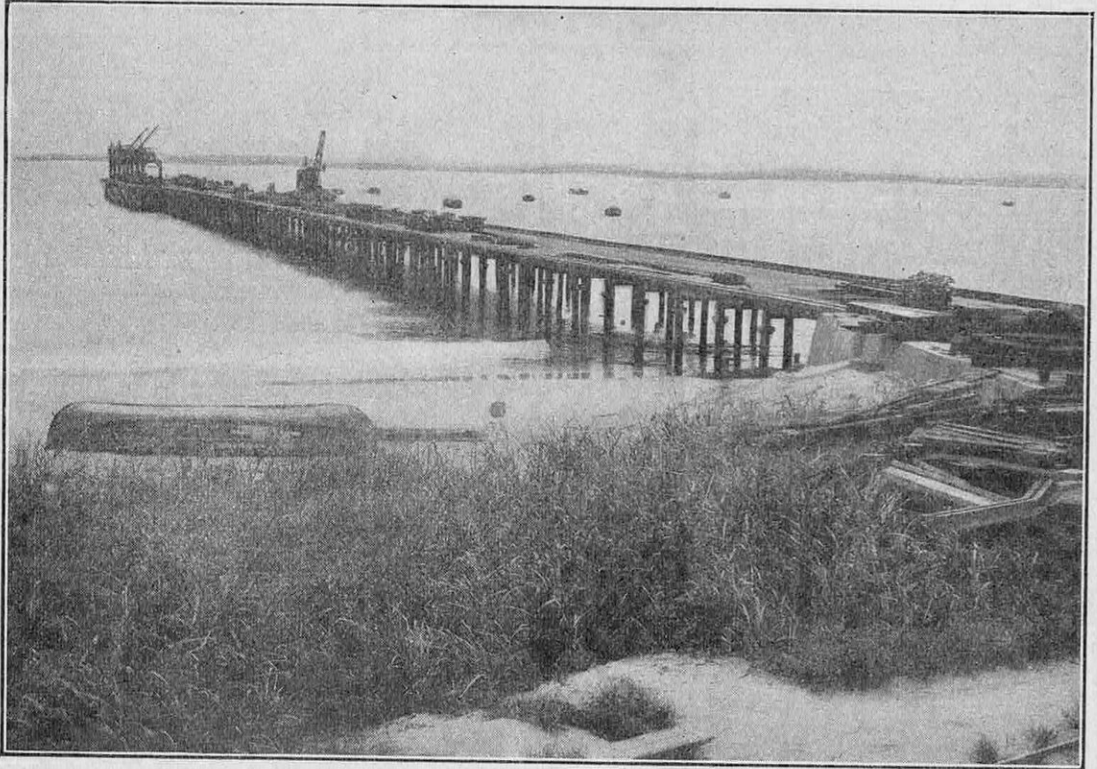
QUAND UNE COLONIE N'A PAS ENCORE DE PORT, ELLE UTILISE UN WHARF : ON VOIT ICI LE WHARF DE POINTE-NOIRE (CONGO), POINT TERMINUS DE LA LIGNE DE CHEMIN DE FER DE BRAZZAVILLE A L'OcéAN ATLANTIQUE
