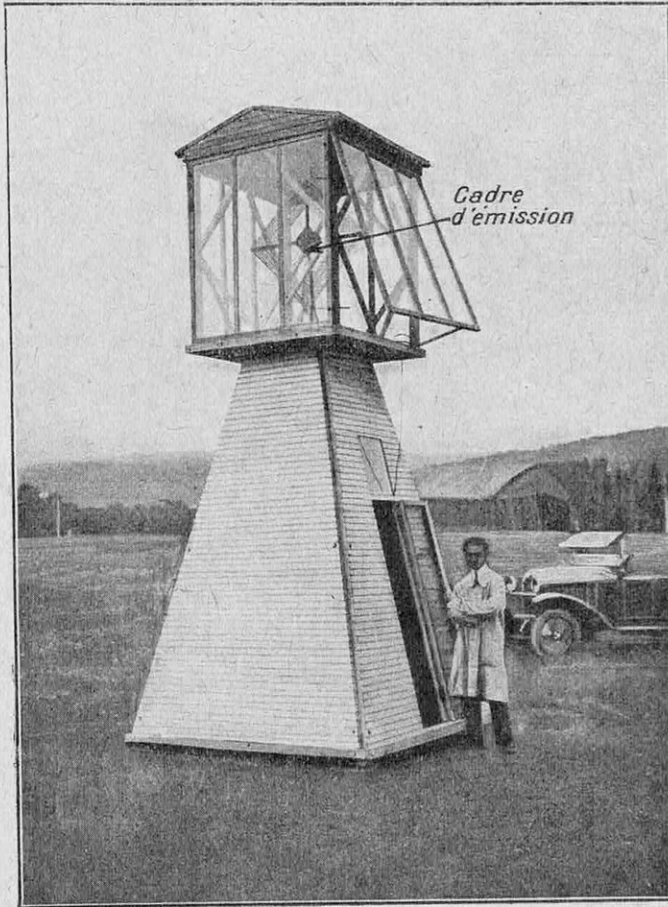
UN DES PHARES HERTZIENS, TRACEURS DE ROUTE, AU CHAMP D'EXPÉRIENCES DE VAUX-SUR-SEINE
