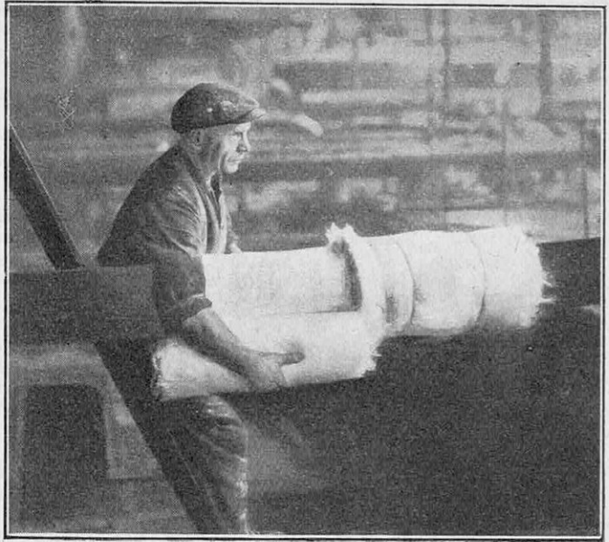
FIG. 9. — ON POSE LA SOIE DE VERRE SUR UN TUYAU EN ENROULANT SIMPLEMENT AUTOUR DE LUI UN OU PLUSIEURS MATELAS DE CE CALORIFUGE
