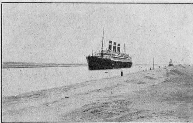
CETTE PHOTOGRAPHIE DU CANAL DE SUEZ FAIT RESSORTIR, PAR OPPOSITION AVEC LA VUE CI-DESSOUS, LA FACILITÉ D'ÉTABLISSEMENT D'UN CANAL DE PLAINE PAR RAPPORT A CELUI D'UN CANAL DE MONTAGNE
