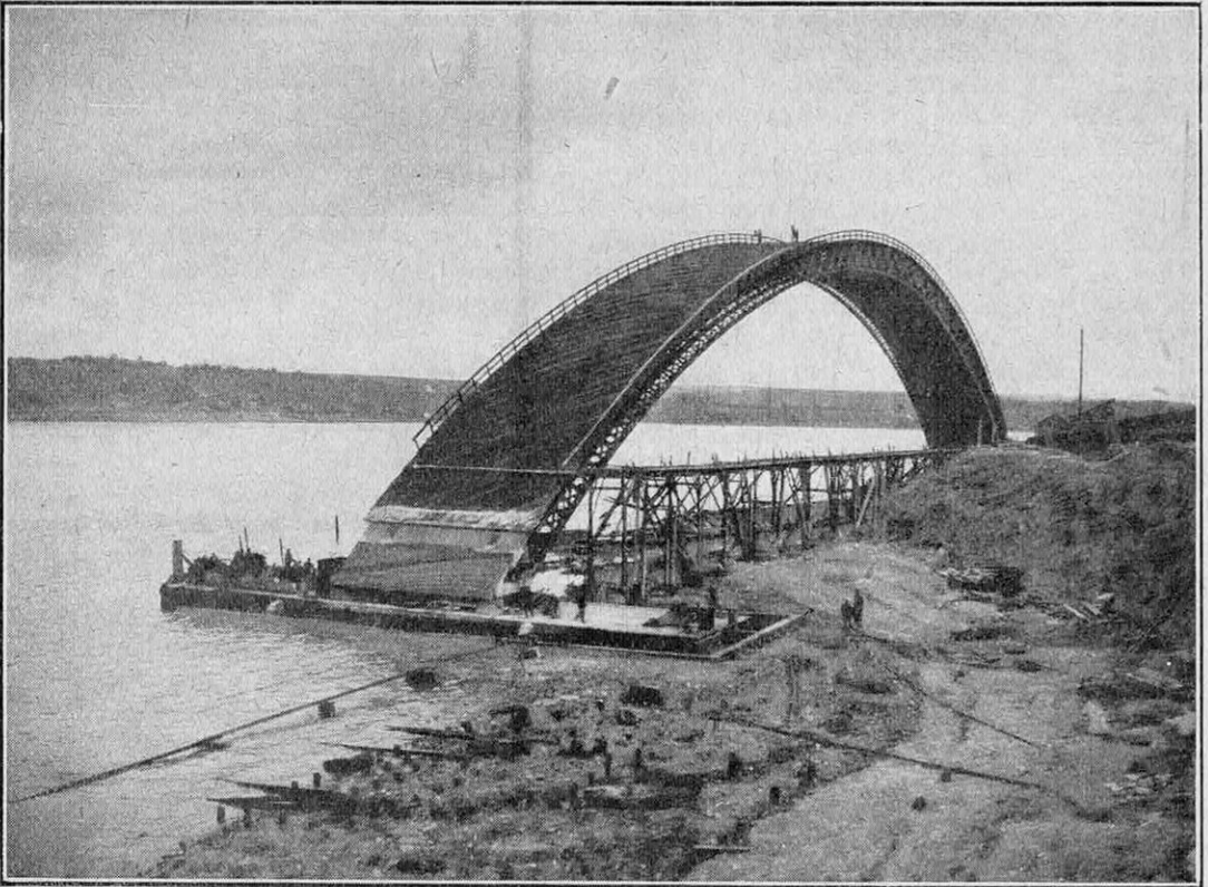
LE CINTRE, QUI SERA EMPLOYÉ A LA CONSTRUCTION SUCCESSIVE DES ARCS, REPOSE, ▲, CHACUNE DE SES EXTRÉMITÉS, SUR UNE EMBARCATION EN CIMENT ARMÉ, QUI SERVIRA A SON TRANSPORT ENTRE LA CULÉE ET LA PREMIÈRE PILE
