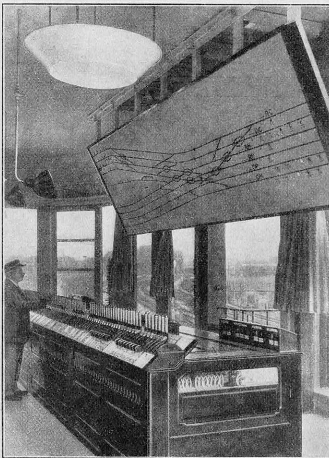
LA CABINE VITRÉE DE SAINT-DENIS OÙ SE TROUVENT LES ORGANES DE COMMANDE DES AIGUILLAGES
