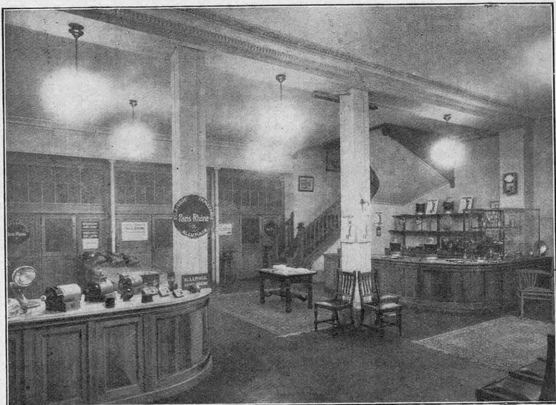
ÉCLAIRAGE D'UN MAGASIN PAR DIFFUSEURS FERMÉS EN VERRE OPALIN
