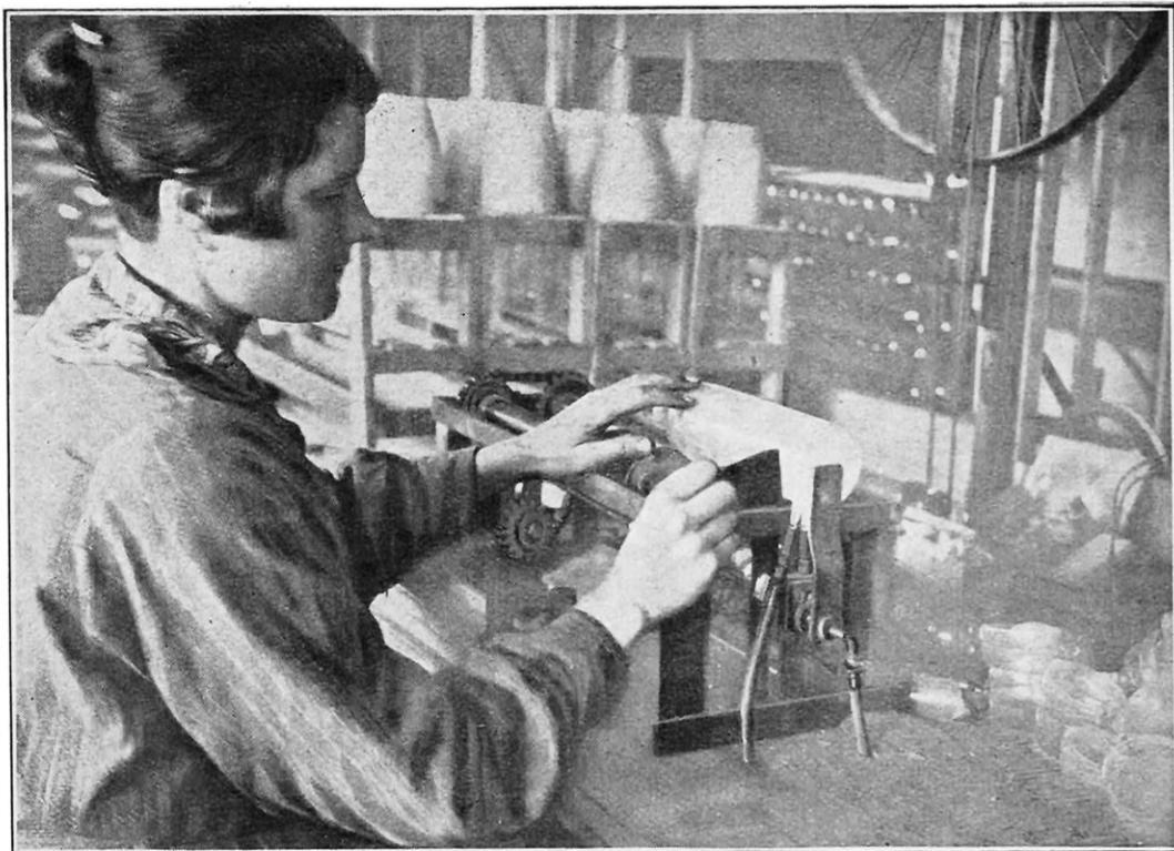
FIG. 2. — COUPAGE DU FOND DE LA BOUTEILLE EXTÉRIEURE
