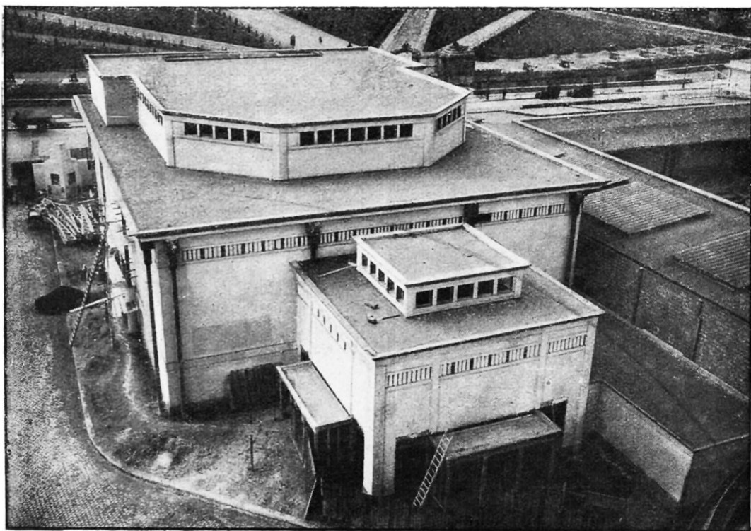
LE THÉÂTRE DE L'EXPOSITION, ÉRIGÉ PAR LES FRÈRES PERRET Vue prise du haut d'une des quatre tours monumentales Plumet.
