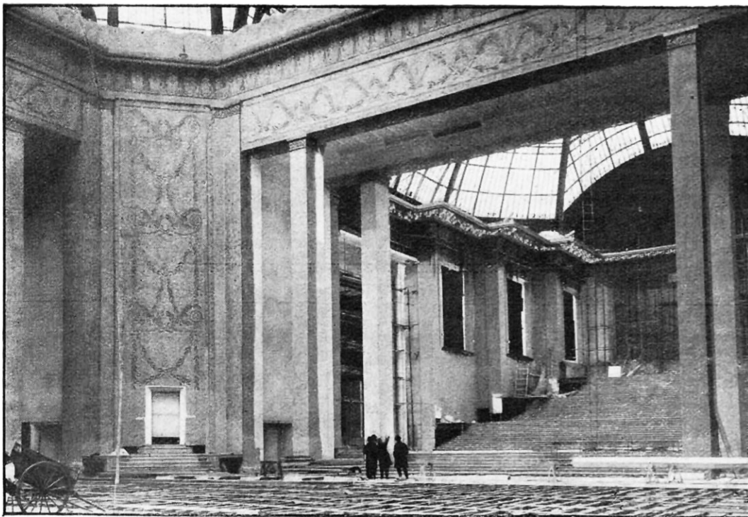
LE GRAND PALAIS MAQUILLÉ. VUE INTÉRIEURE PRISE TANDIS QUE L'ARCHITECTE CHARLES LETROSNE CONFÉRAIT AVEC SES ENTREPRENEURS AU SUJET DE L'ACHÈVEMENT DES TRAVAUX DANS LA ROTONDE PRINCIPALE
