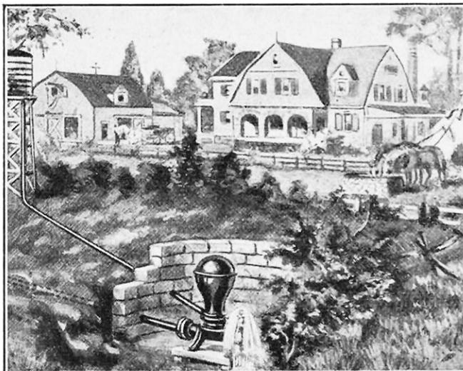
ÉLÉVATION D'EAU PAR BÉLIER GOULDS-FILTER DANS UNE EXPLOITATION AGRICOLE
