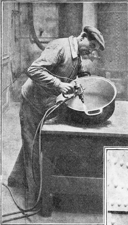
MÉTALLISATION D'UNE CUVE A L'AIDE DU PISTOLET MÉTALLISEUR
