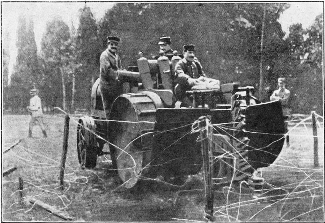
FIG. 2. — SECOND APPAREIL DE M. J.-L. BRETON POUR COUPER LES FILS BARBELÉS
