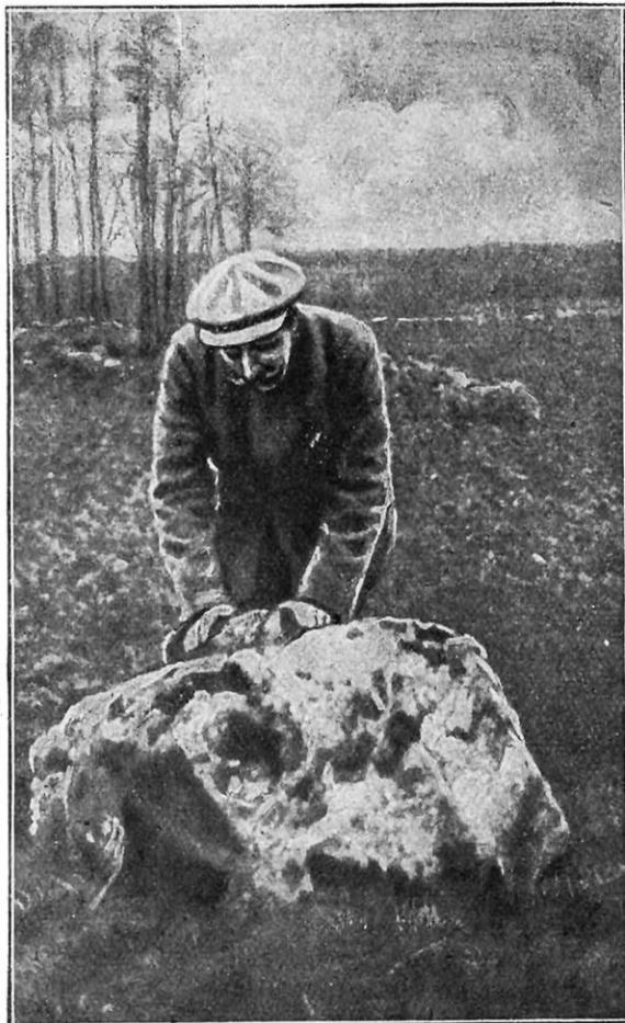
UNE CALOTTE DE BOUE RECOUVRE LA CHARGE DE DYNAMITE
