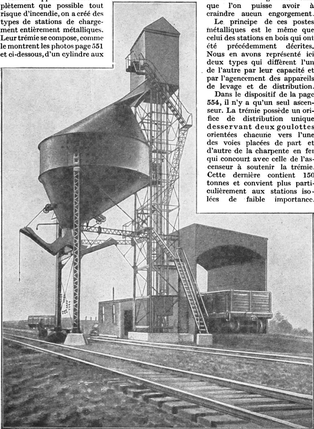
POSTE DE CHARGEMENT ENTIÈREMENT MÉTALLIQUE, CONTENANT 150 TONNES
