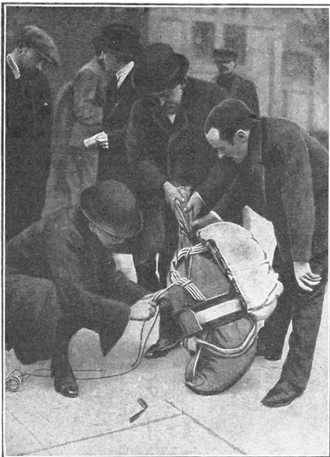
ESSAI, A LA TOUR EIFFEL, D'UN NOUVEAU SYSTÈME DE PARACHUTE POUR AVIONS
