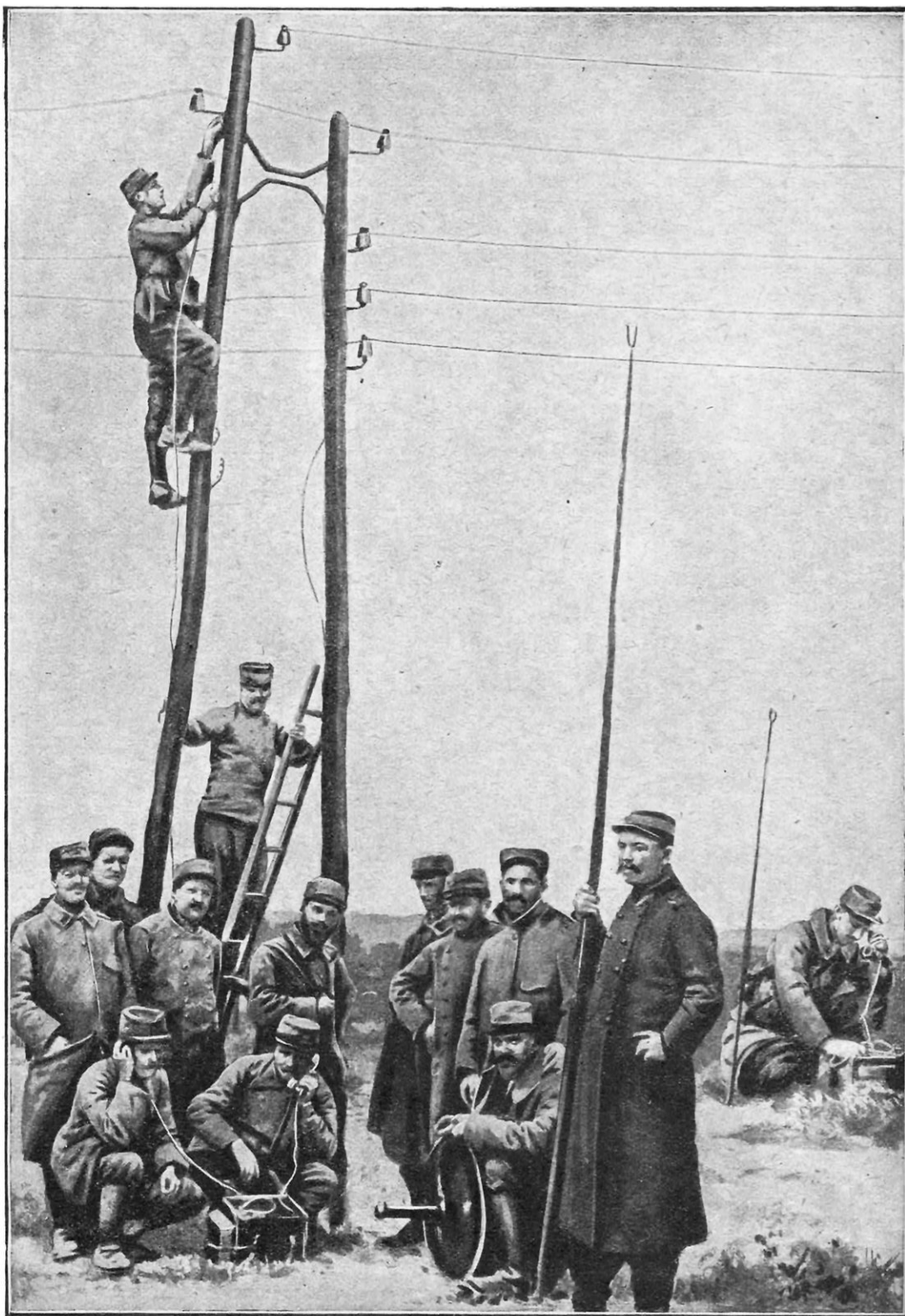
INSTALLATION PROVISOIRE D'UNE LIGNE TÉLÉPHONIQUE VOLANTE DE CAMPAGNE La pose de cette ligne se fait sur les poteaux télégraphiques ordinaires d'une grande route.
