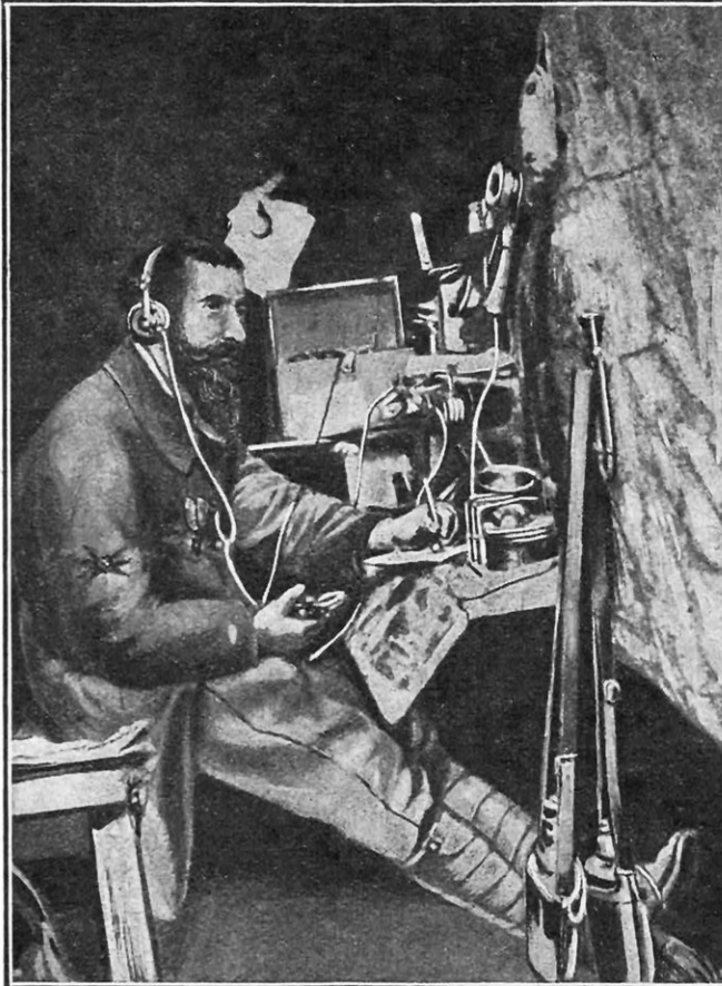
POSTE TÉLÉPHONIQUE DANS UN RÉDUIT SOUTERRAIN
