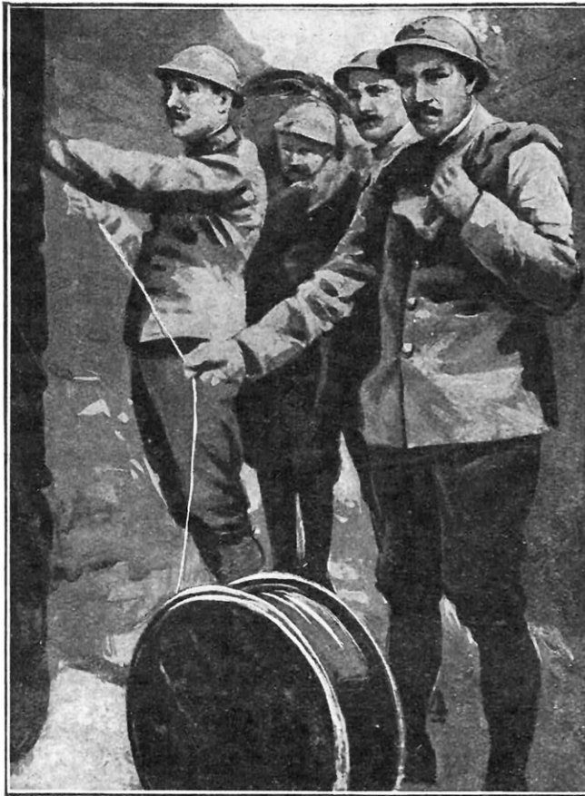
POSE D'UNE LIGNE TÉLÉPHONIQUE DANS UNE TRANCHEE
