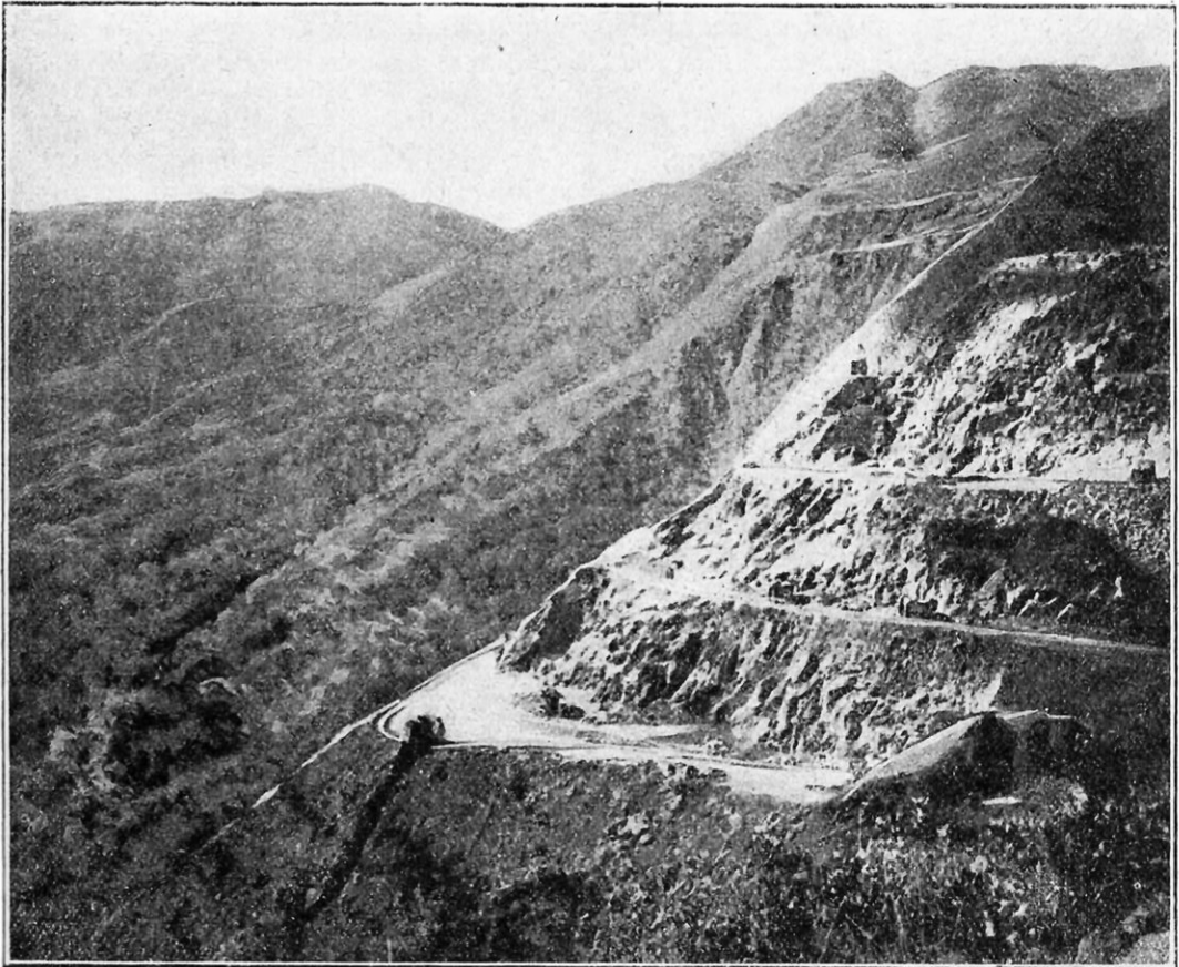
MÉTHODE D'EXPLOITATION EMPLOYÉE POUR L'ABATAGE DES MINÉRAIS
