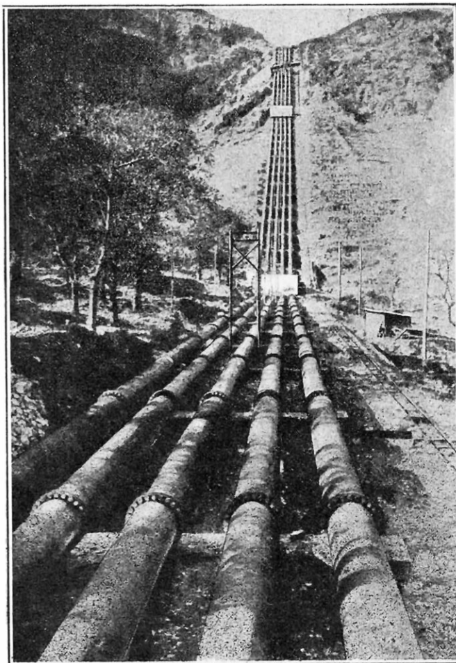
CONDUITES D'AMENÉE D'EAU AUX TURBINES
