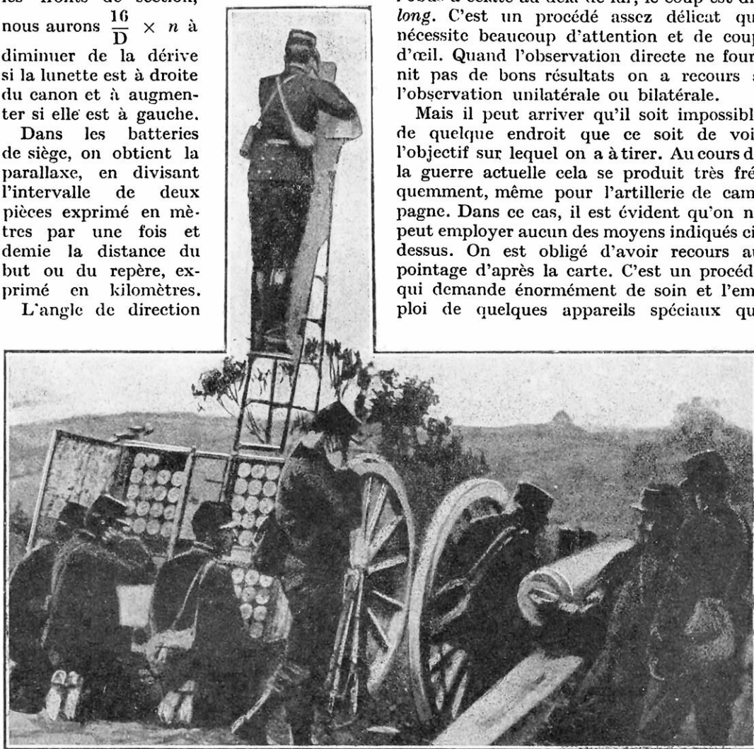
ÉCHELLE-OBSERVATOIRE MOBILE D'UNE BATTERIE D'ARTILLERIE LÉGÈRE
