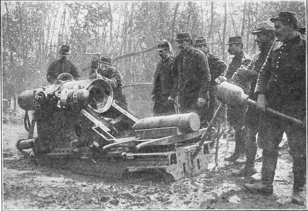
MORTIER DE 220 MILLIMÈTRES ; PORTÉE : 8 KILOMÈTRES ; POIDS DE L'OBUS : 100 KILOGRAMMES
