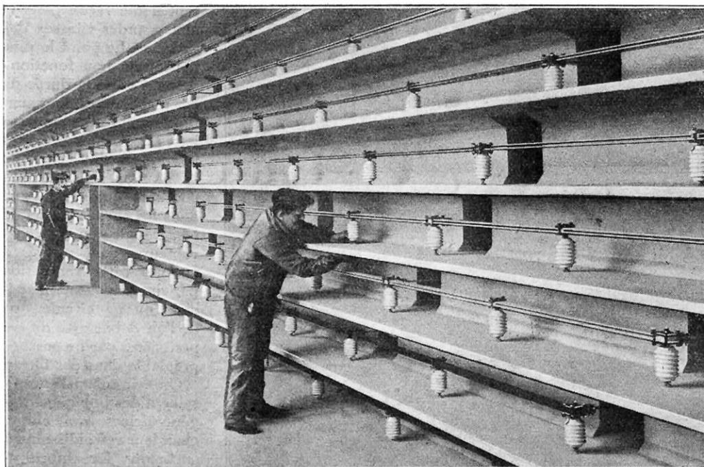
C'EST PAR CES BARRES QUE S'ÉCOULE L'ÉNERGIE ÉLECTRIQUE PRODUITE PAR LA CENTRALE
