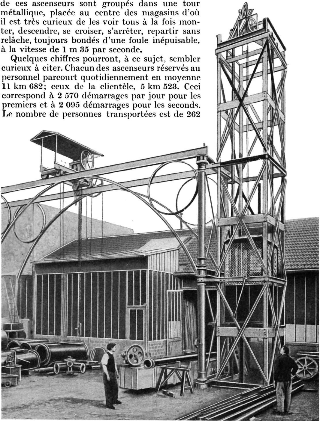
CAGE D'ESSAI POUR ASCENSEURS ÉLECTRIQUES
