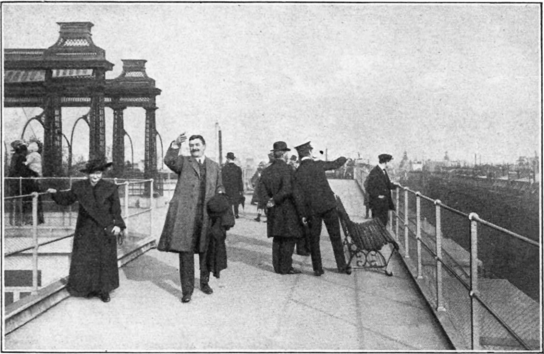
La photographie ci-dessus a été prise sur le toit des Magasins des Galeries Lafayette. C'est une terrasse aussi vaste qu'un square et à laquelle le public a libre accès. En dessous, photographie du toit de l'Automobile-Club, place de la Concorde. Il a été aménagé, on le voit, en un jardin délicieux.
