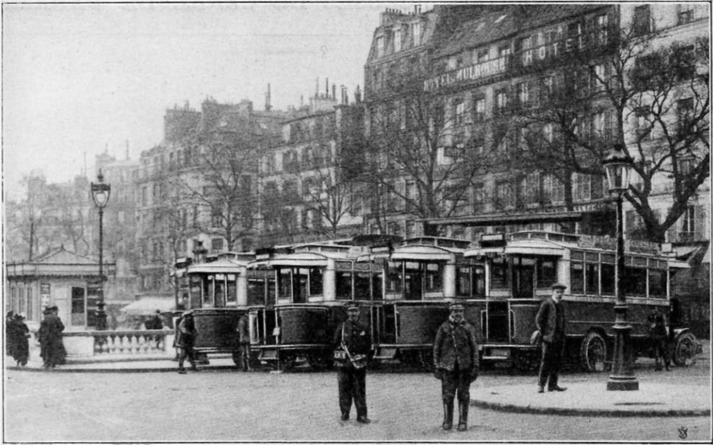
UN TERMINUS IMPORTANT. — LIGNE TROCADÉRO-GARE DE L'EST
